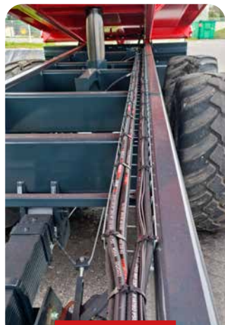
PASSAGE DES FLEXIBLES DANS CHEMIN DE CÂBLES
